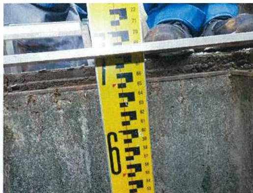
雨水桝-◇C◇ 桝深さ測定近景
