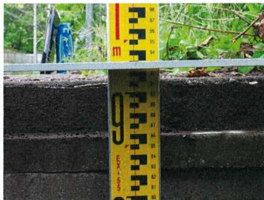
汚水桝-⑰ 桝深さ測定近景
