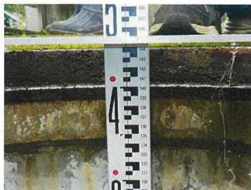
汚水桝-㊼ 桝深さ測定近景
