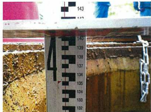
汚水桝-②⑦ 桝深さ測定近景
