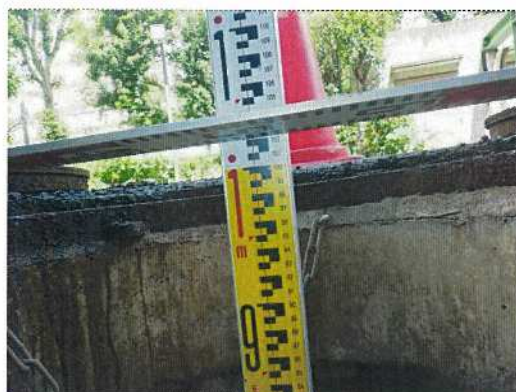
雨水桝-37 桝深さ測定近景
