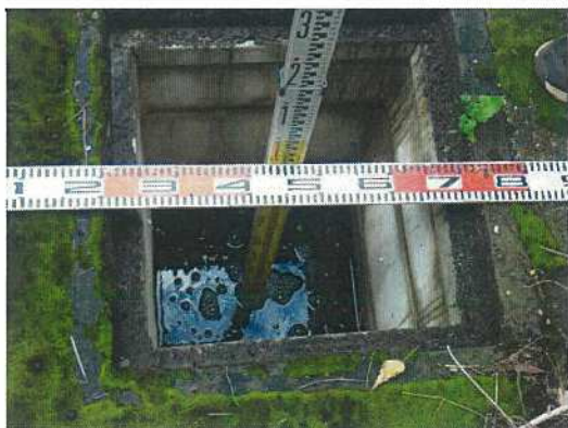
雨水桝-40 桝深さ測定状況
