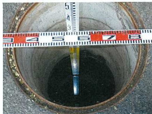
雨水桝-66 桝深さ測定状況
