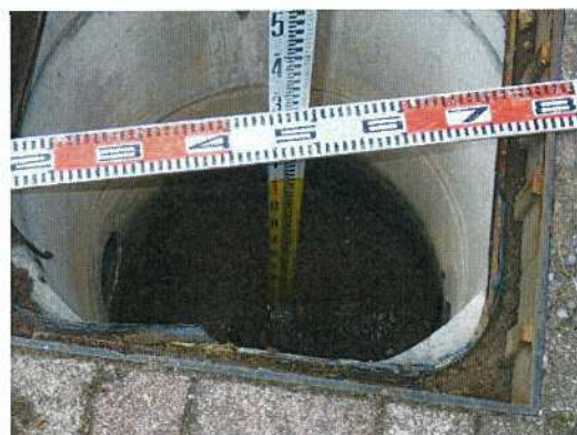
雨水桝-51 桝深さ測定状況
