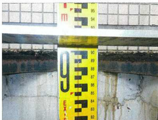
雨水桝-45 桝深さ測定近景
