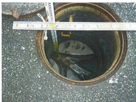
汚水枡-⑳ 枡深さ測定状況
