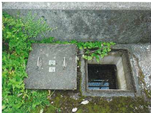
雨水桝-◇B◇ 調査前
