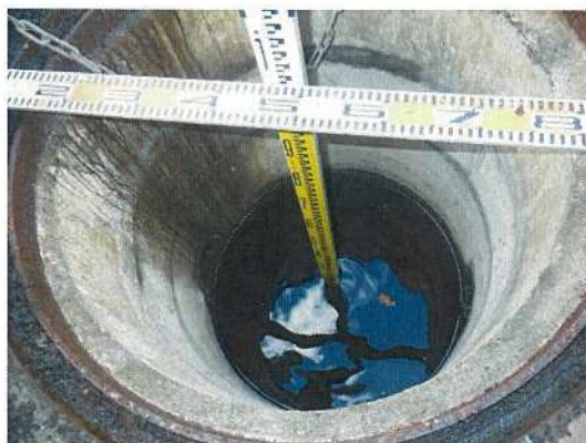
写真 2-2 樹深さ測定(雨水枡)
