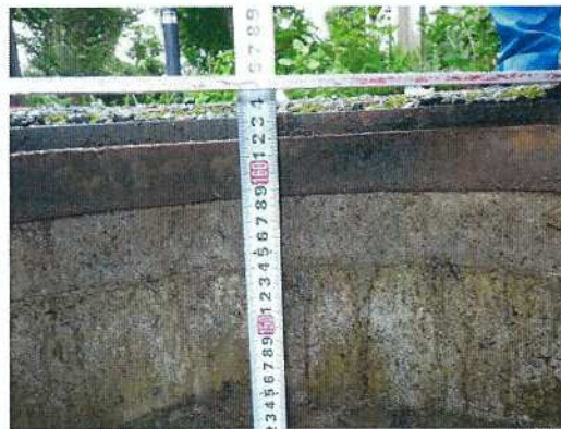
雨水桝-35 配管深さ測定近景(34側)
