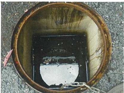
雨水桷-64 桷内部全景
