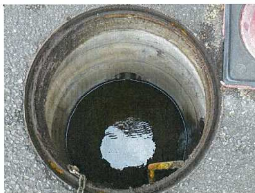
雨水桝-65 桝内部全景
