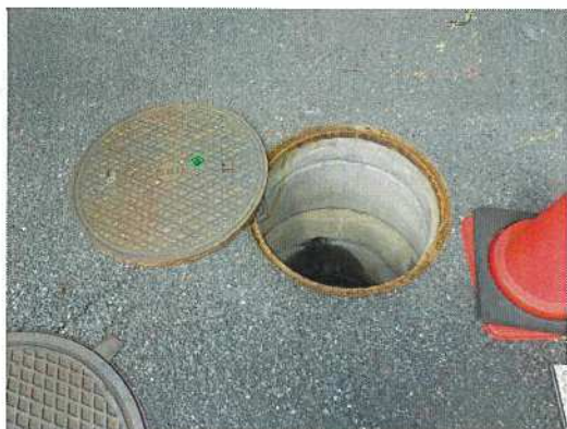
雨水桝-67 調査前
