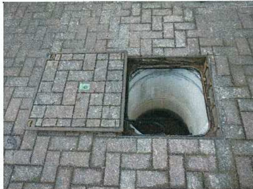
雨水桝-51 調査前
