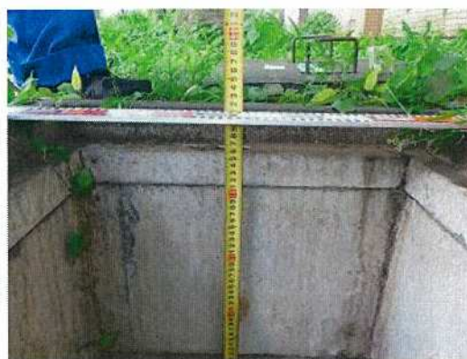
雨水桝-21 配管深さ測定状況(20側)
