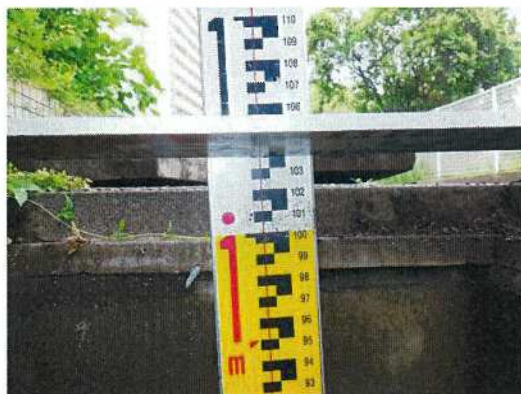
雨水桝-17 桝深さ測定近景
