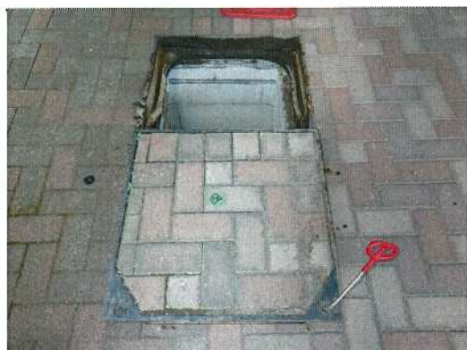
雨水桝-58 調査前
