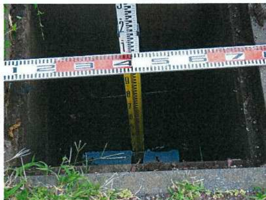
雨水桝-17 桝深さ測定状況
