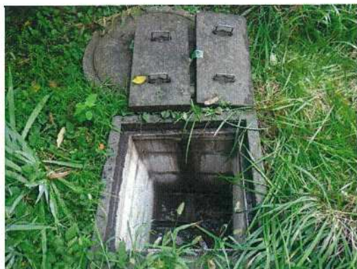
汚水桝-⑬ 調査前
