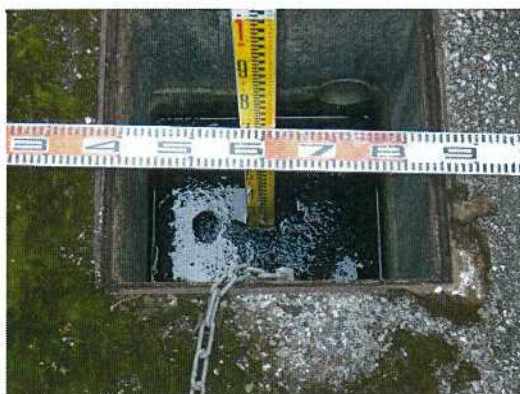
雨水桝-◇C◇ 桝深さ測定状況
