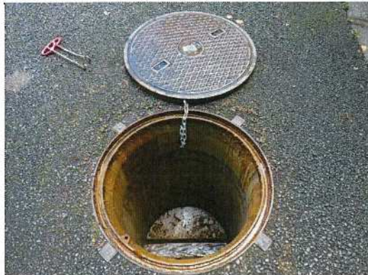
汚水桝-②⑦ 調査前
