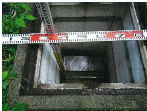
汚水桝-㉓ 桝深さ測定状況
