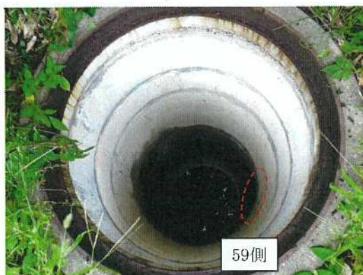
雨水桝-60 桝内部全景
