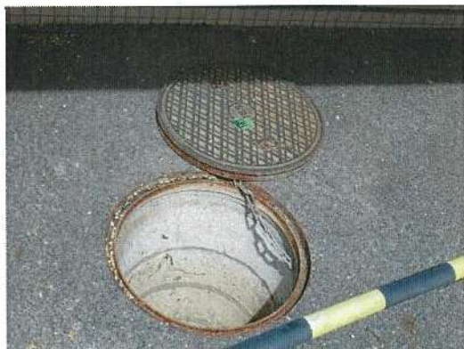
雨水桝-66 調査前
