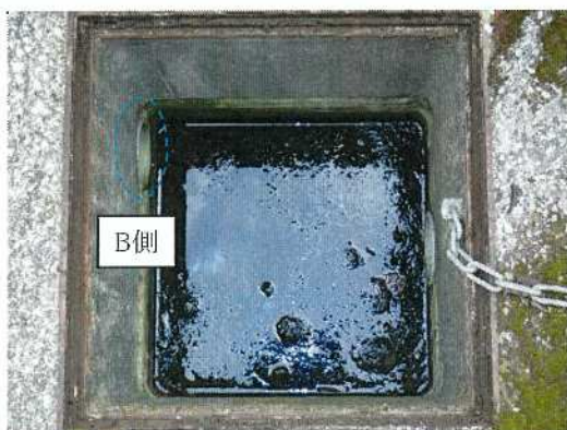
雨水桝-◇C◇ 桝内部全景
