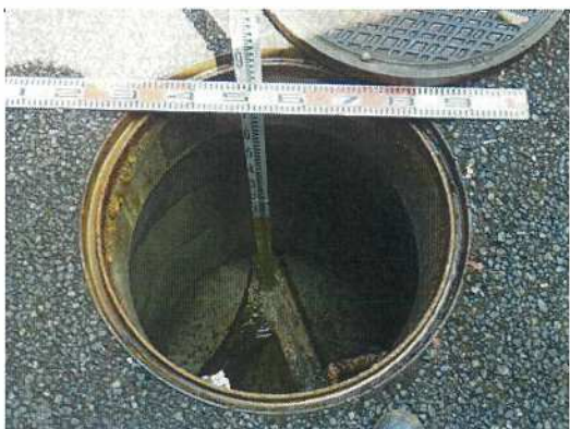
汚水桝-38 桝深さ測定状況
