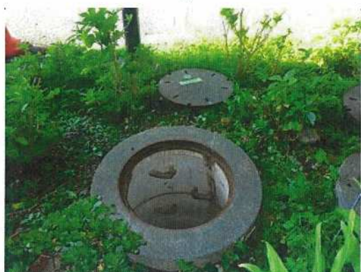
雨水桝-34 調査前
