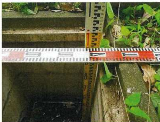
雨水桝-20 桝深さ測定近景
