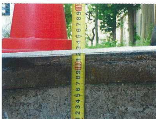
雨水桝-24 配管深さ測定近景(23側)
