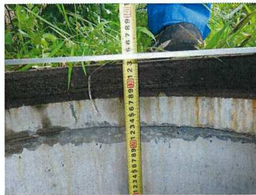
雨水桝-60 配管深さ測定近景(59側)
