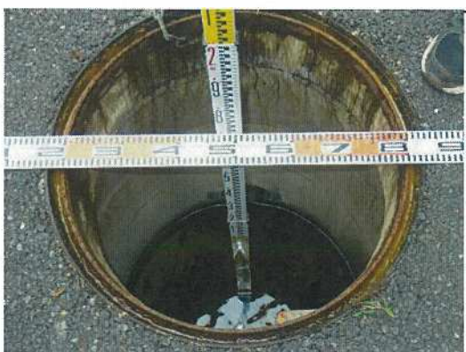
雨水桝-63 桝深さ測定状況
