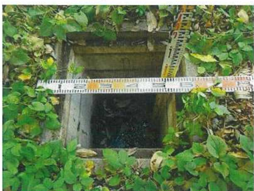
雨水桝-19 桝深さ測定状況
