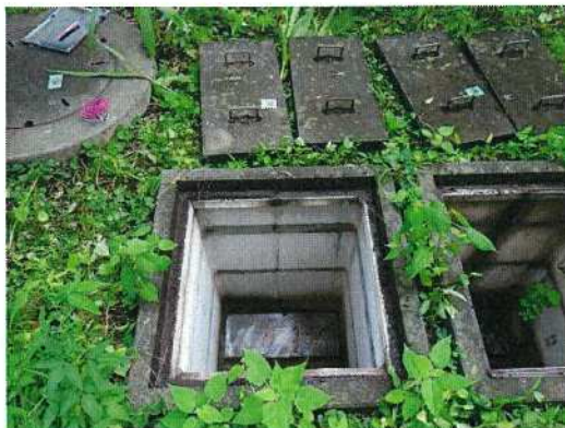
汚水桝-㉓ 調査前
