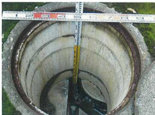
汚水桝-㊼ 桝深さ測定状況
