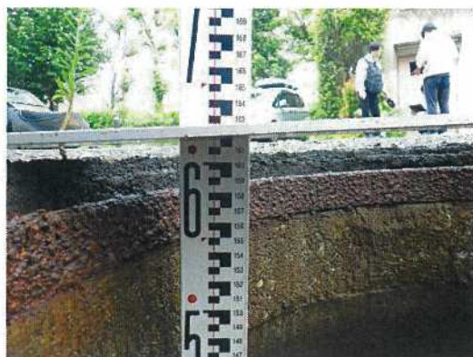
汚水桝-③⑩ 桝深さ測定近景
