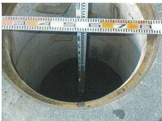
雨水桝-34 桝深さ測定状況
