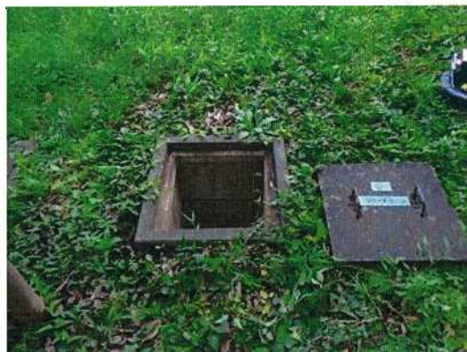
雨水桝-21 調査前
