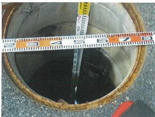
雨水桝-67 桝深さ測定状況
