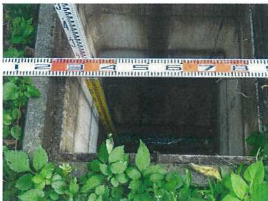
汚水枥-⑳ 枥深さ測定状況
