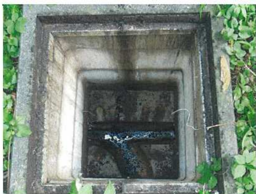
汚水枥-⑳ 枥内部全景
