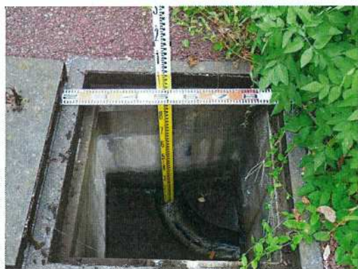
汚水桝-⑰ 桝深さ測定状況
