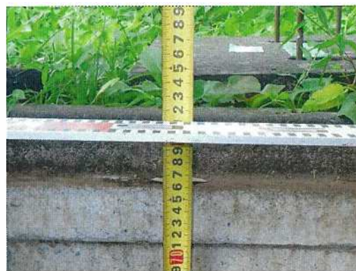
雨水桝-21 配管深さ測定近景(20側)
