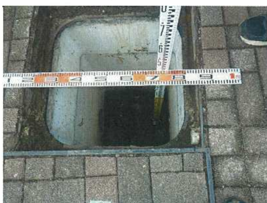
雨水桝-59 桝深さ測定状況
