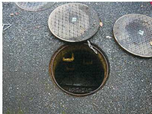
汚水桝-29 調査前
