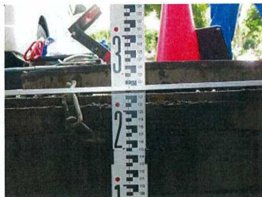
雨水桝-25 桝深さ測定状況
