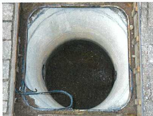
雨水桝-51 桝内部全景
