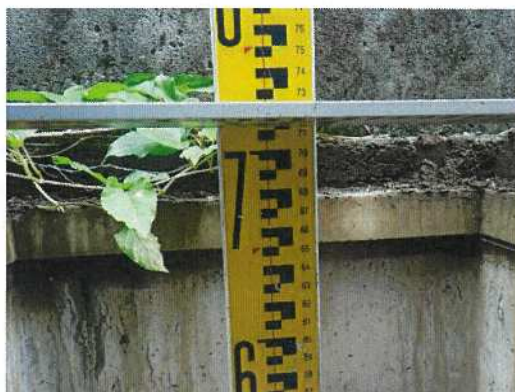
雨水桝-◇B◇ 桝深さ測定近景
