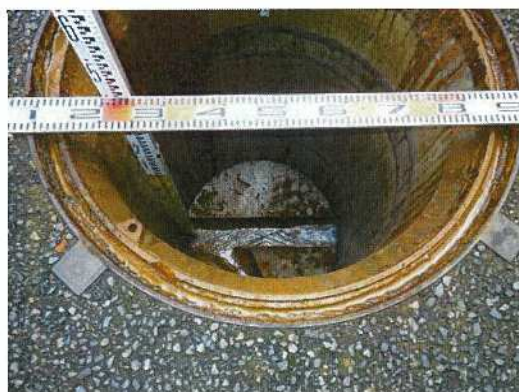
汚水桝-②⑦ 桝深さ測定状況
