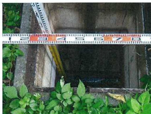
汚水桝-②① 桝深さ測定状況
