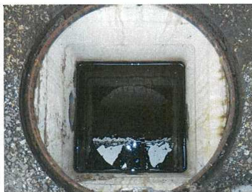
雨水桝-45 桝内部全景
