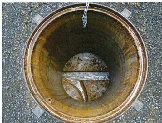
汚水桝-②⑦ 桝内部全景
