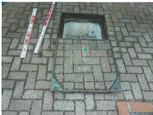
雨水桝-59 調査前
