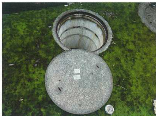
汚水桝-㊼ 調査前
