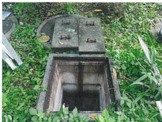
汚水枥-⑳ 調査前
