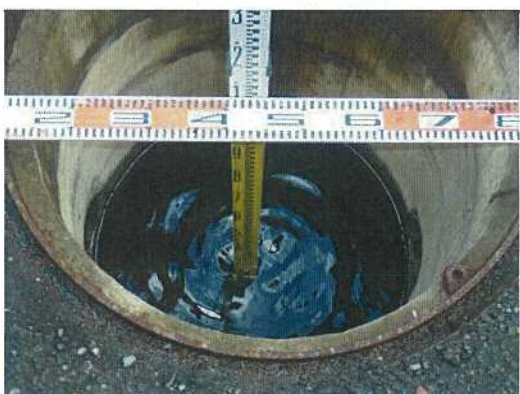
雨水桝-38 桝深さ測定状況
