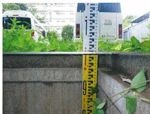
雨水桝-21 桝深さ測定状況
