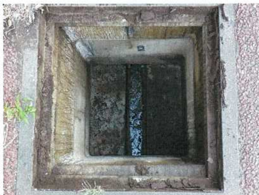
汚水枥-⑥ 枥内部全景
