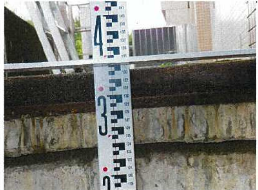
汚水桝-③④ 桝深さ測定近景
