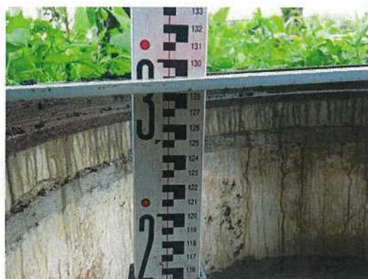
汚水桝-②④ 桝深さ測定近景
