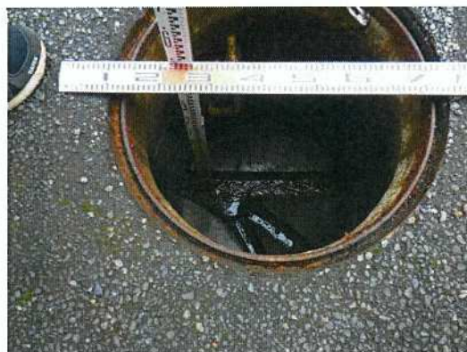
汚水桝-29 桝深さ測定状況
