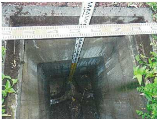
汚水桝-⑱ 桝深さ測定状況
