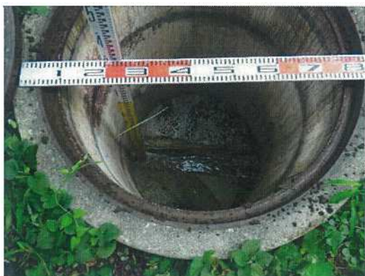
汚水桝-②④ 桝深さ測定状況
