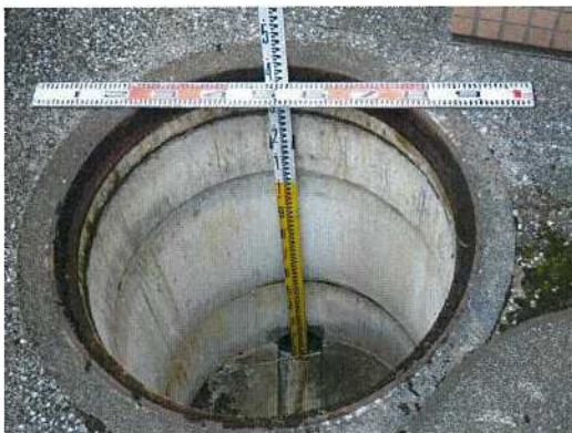
汚水桝-③④ 桝深さ測定状況
