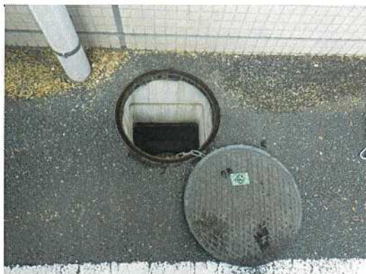
雨水桝-44 調査前
