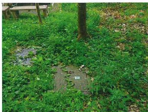
雨水桝-20 調査前
