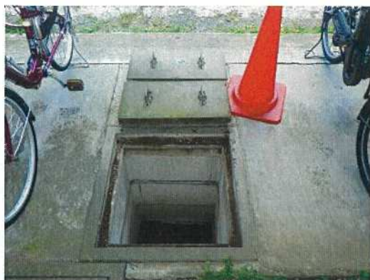
雨水桝-26 調査前
