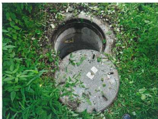
汚水桝-③③ 調査前
