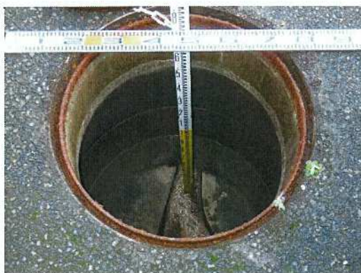
汚水桝-③① 桝深さ測定状況
