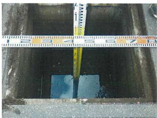
雨水桝-16 桝深さ測定状況
