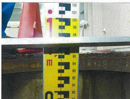
雨水桷-64 桷深さ測定近景
