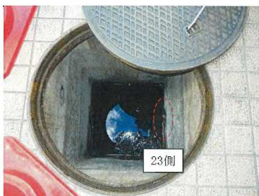
雨水桝-24 桝内部全景
