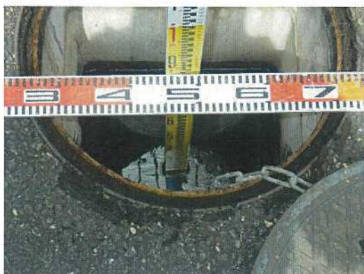
雨水桝-44 桝深さ測定状況
