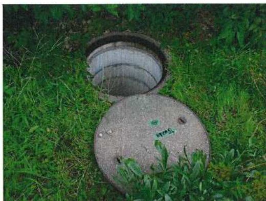
雨水桝-60 調査前
