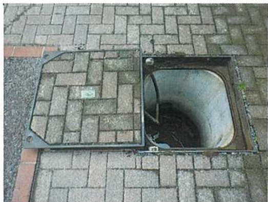
雨水桝-50 調査前
