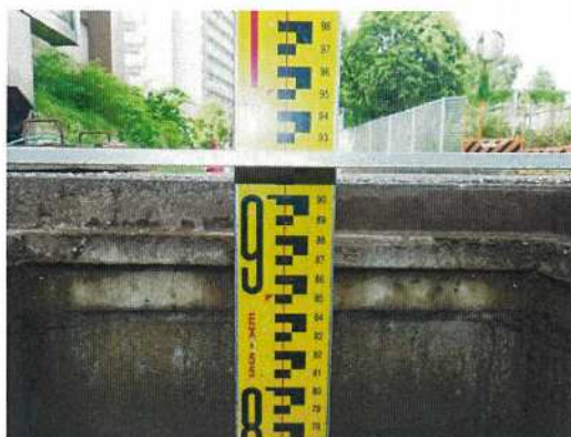
雨水桝-16 桝深さ測定近景
