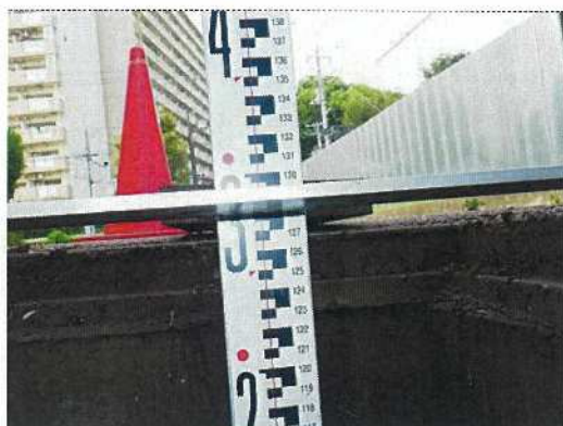
雨水桝-18 桝深さ測定近景
