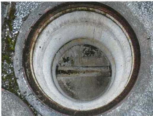
汚水桝-③④ 桝内部全景
