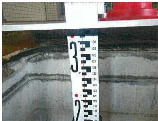
雨水桝-58 桝深さ測定近景
