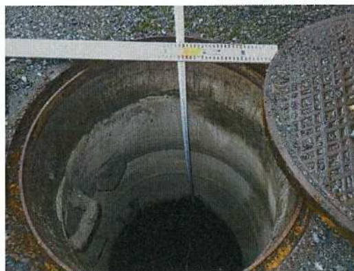
雨水桝-35 配管深さ測定状況(34側)
