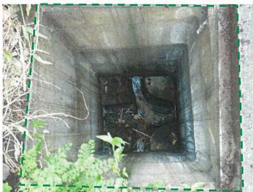
汚水桝-⑱ 桝内部全景
