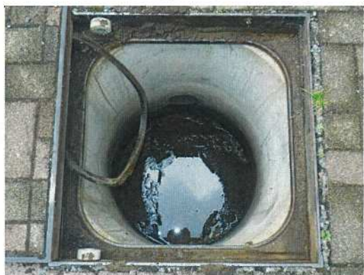
雨水桝-50 桝内部全景
