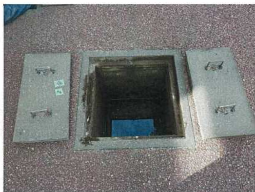
雨水桝-16 調査前
