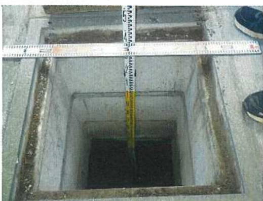
雨水桝-26 桝深さ測定状況
