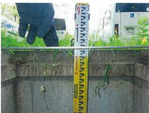
雨水桝-22 桝深さ測定状況
