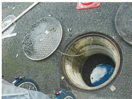
雨水桝-37 調査前
