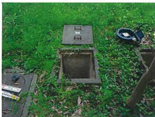
雨水桝-22 調査前
