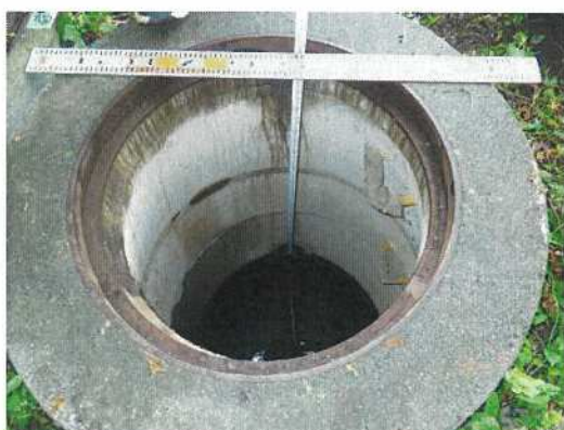
雨水桝-34 配管深さ測定状況 (35側)
