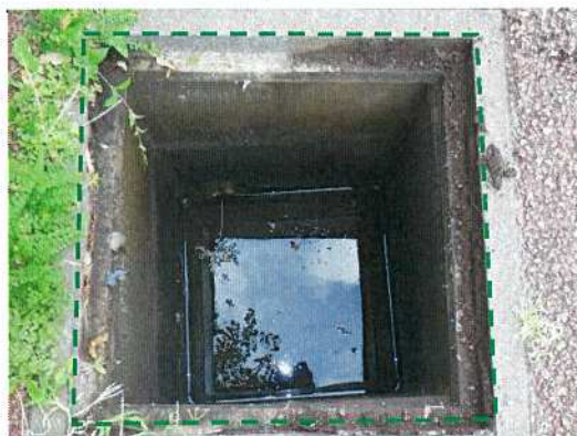
雨水桝-17 桝内部全景
