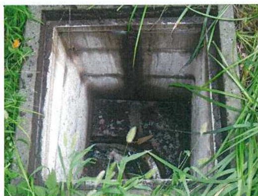
汚水桝-⑬ 桝内部全景
