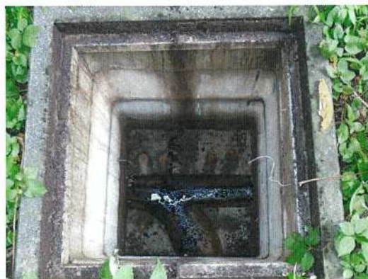
汚水桝-②① 桝内部全景
