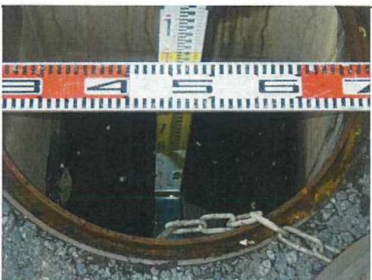
雨水桷-64 桷深さ測定状況
