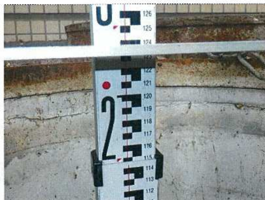
雨水桝-66 桝深さ測定近景
