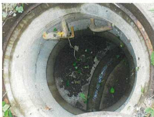
汚水桝-③③ 桝内部全景
