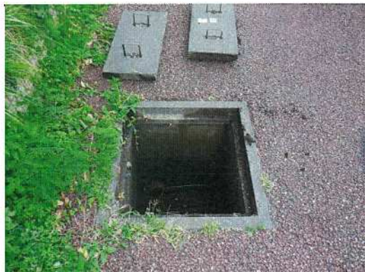
雨水桝-17 調査前
