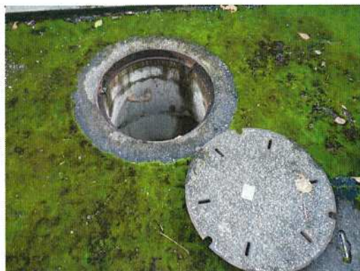
汚水枥-③⑦ 調査前
