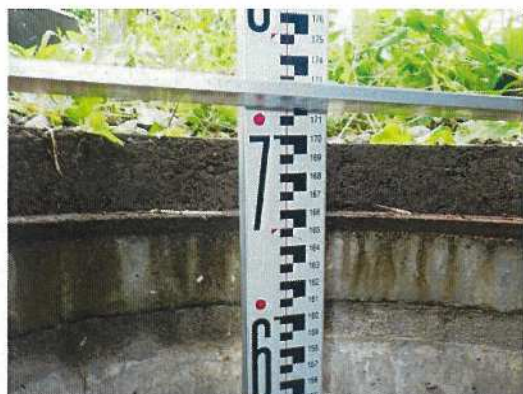
汚水桝-③③ 桝深さ測定近景
