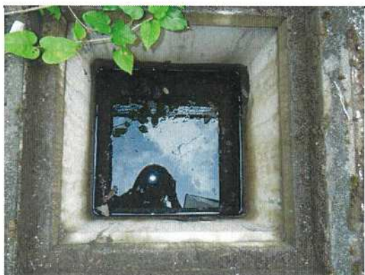
雨水桝-◇B◇ 桝内部全景
