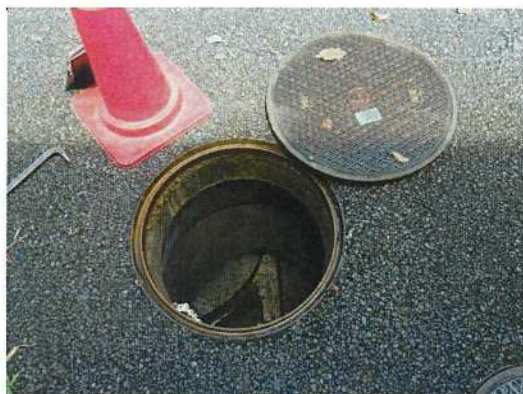
汚水桝-38 調査前
