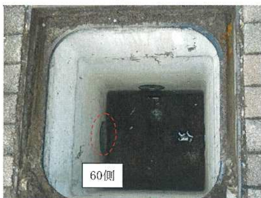
雨水桝-59 桝内部全景
