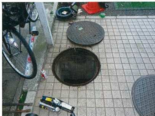
雨水桝-25 調査前
