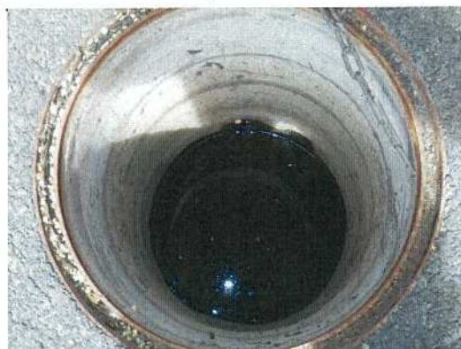
雨水桝-66 桝内部全景
