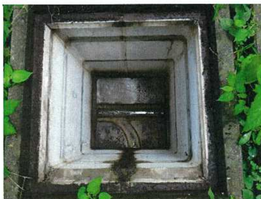
汚水桝-㉓ 桝内部全景
