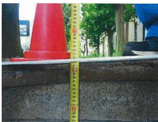
雨水桝-24 配管深さ測定状況(23側)
