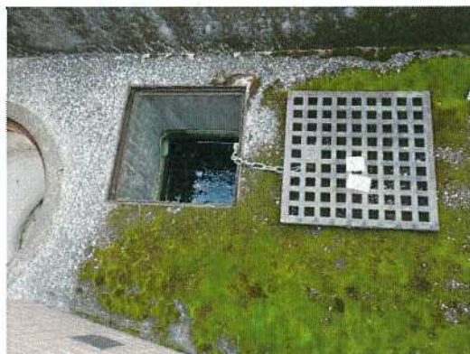
雨水桝-◇C◇ 調査前
