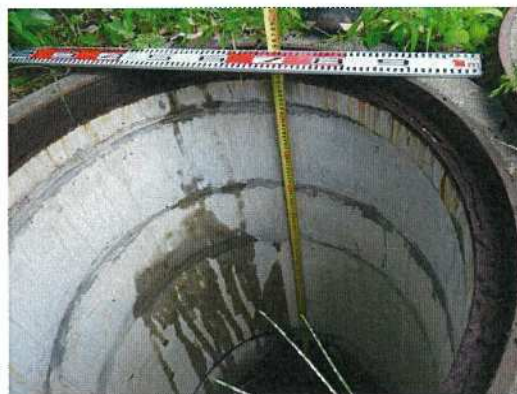
雨水桝-60 配管深さ測定状況(59側)
