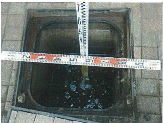
雨水桝-55 桝深さ測定状況
