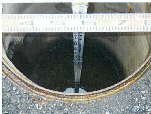
雨水桝-39 桝深さ測定状況
