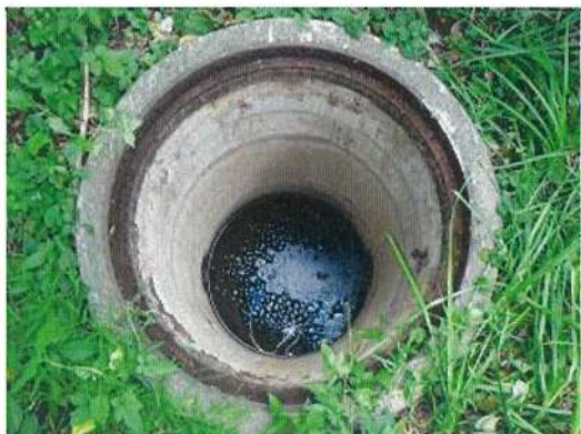
雨水桝-28 桝内部全景
