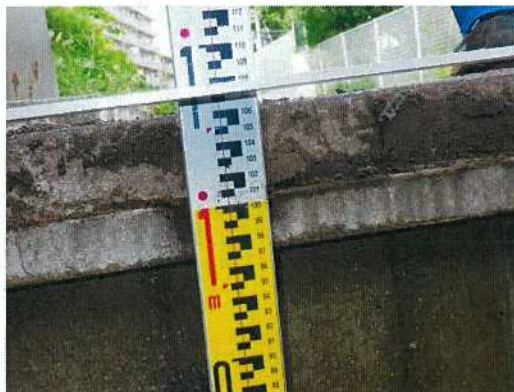
汚水枥-⑥ 枥深さ測定近景
