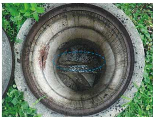
汚水桝-②④ 桝内部全景
