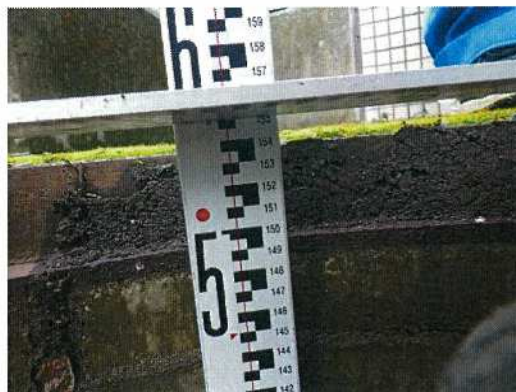
汚水枥-③⑦ 枥深さ測定近景
