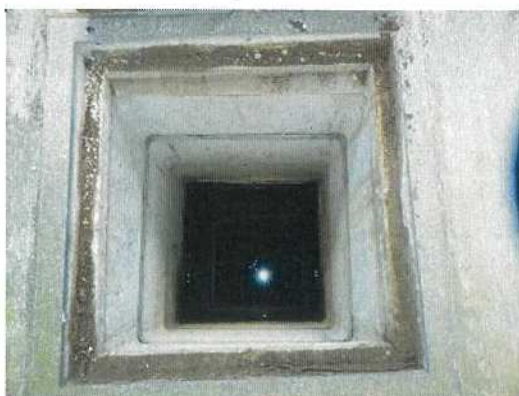
雨水桝-26 桝内部全景
