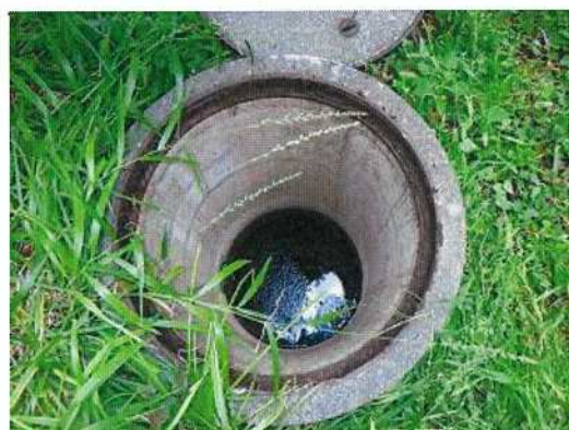
雨水桝-27 桝内部全景
