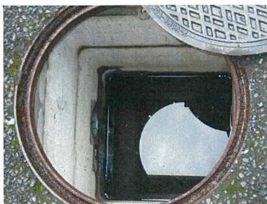
雨水桝-36 桝内部全景
