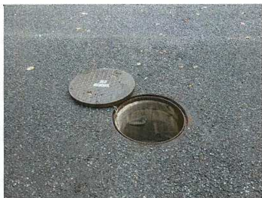
雨水桝-39 調査前
