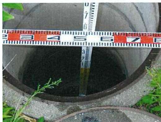
雨水桝-60 桝深さ測定状況
