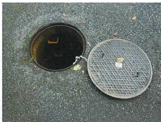
汚水桝-③⑩ 調査前
