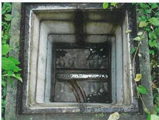
汚水桝-② 桝内部全景
