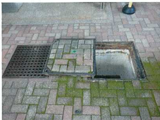
雨水桝-56 調査前
