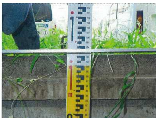
雨水桝-22 桝深さ測定近景
