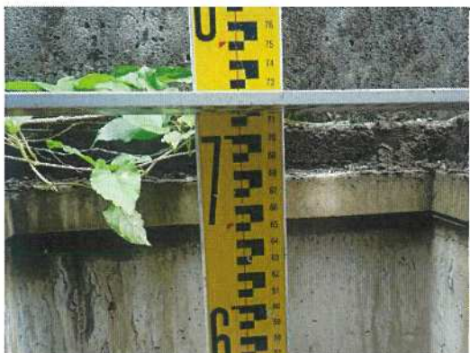
雨水桝-◇B◇ 桝深さ測定状況
