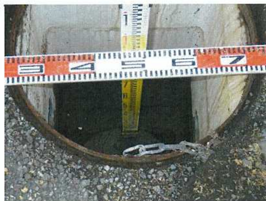
雨水桝-45 桝深さ測定状況
