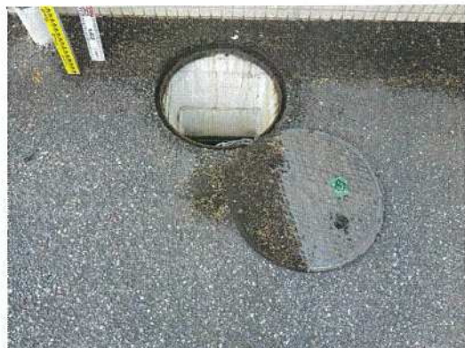
雨水桝-45 調査前
