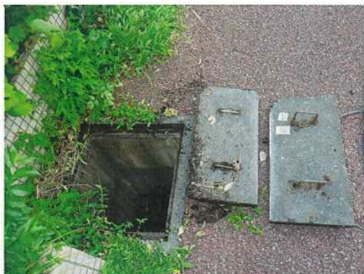
汚水桝-⑱ 調査前
