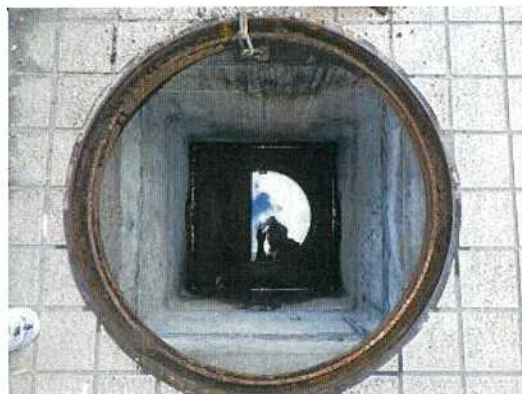
雨水桝-25 桝内部全景
