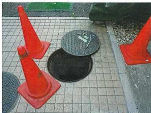
雨水桝-24 調査前
