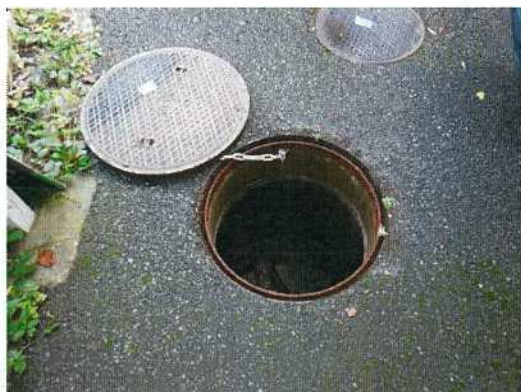
汚水桝-③① 調査前
