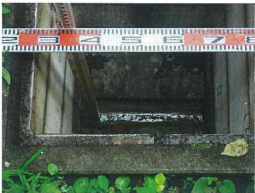
汚水桝-② 桝深さ測定状況
