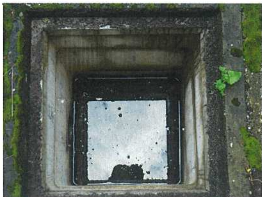
雨水桝-40 桝内部全景
