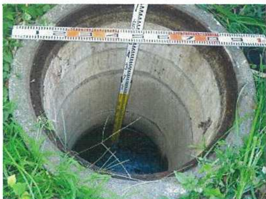
雨水桝-28 桝深さ測定状況
