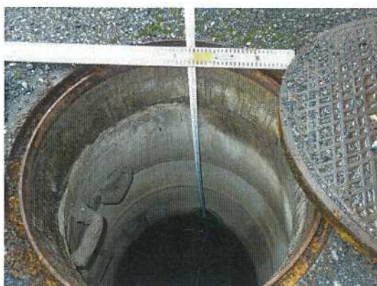
写真 2-4 接続管接続状況調査
