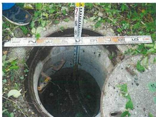
汚水桝-③③ 桝深さ測定状況
