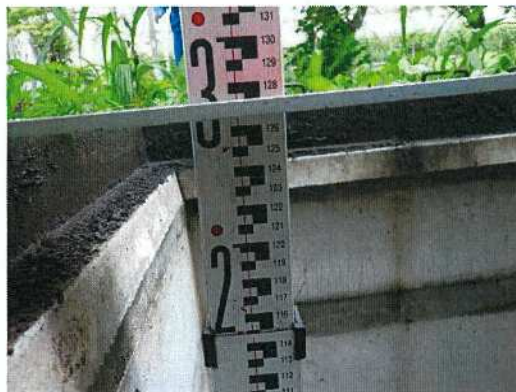
汚水桝-㉓ 桝深さ測定近景
