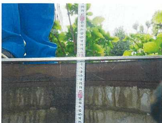
雨水桝-34 配管深さ測定近景 (35側)
