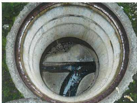
汚水桝-㊼ 桝内部全景
