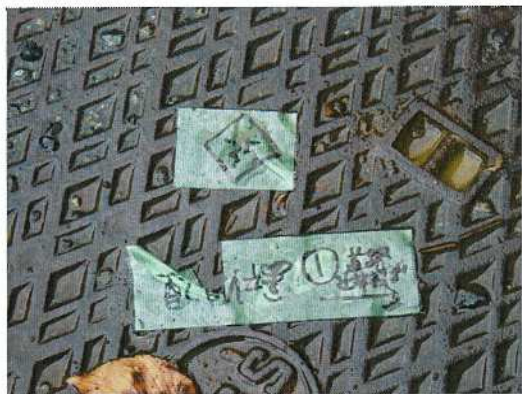
雨水桝-35 調査前
