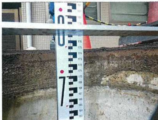
雨水桝-65 桝深さ測定近景
