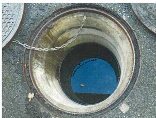
雨水桝-37 桝内部全景
