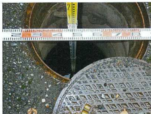
雨水桝-35 桝深さ測定状況
