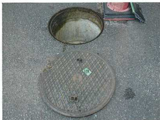
雨水桝-65 調査前
