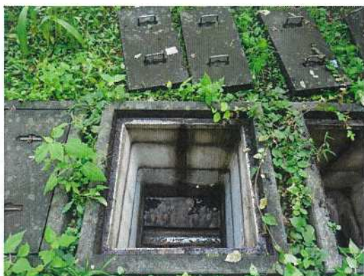
汚水桝-② 調査前
