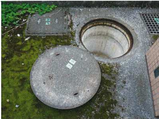
汚水桝-③④ 調査前
