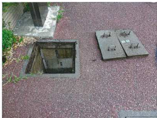
汚水枥-⑥ 調査前
