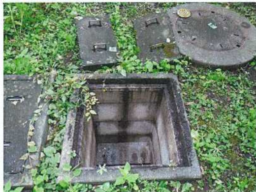
汚水桝-②① 調査前
