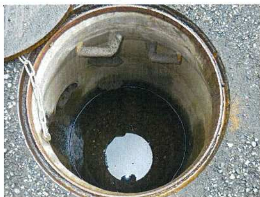
雨水桝-39 桝内部全景
