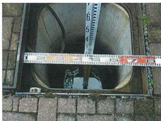
雨水桝-50 桝深さ測定状況
