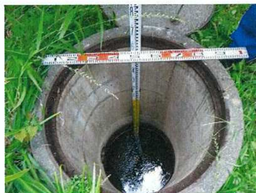
雨水桝-27 桝深さ測定状況
