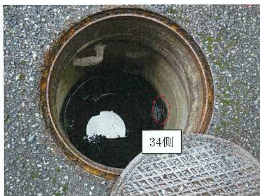
雨水桝-35 桝内部全景
