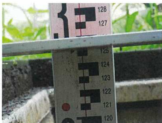
汚水桝-② 桝深さ測定近景
