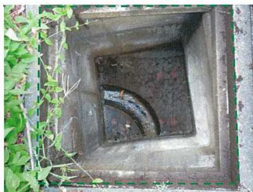
汚水桝-⑰ 桝内部全景
