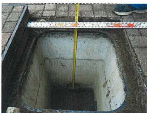
雨水桝-59 配管深さ測定状況 (60側)
