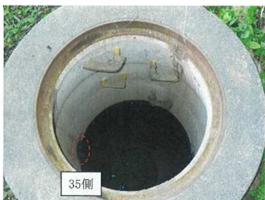
雨水桝-34 桝内部全景
