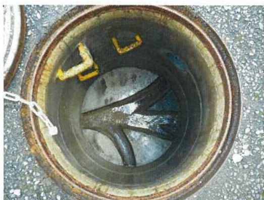
汚水枡-⑳ 枡内部全景
