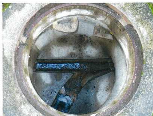
汚水枥-③⑦ 枥内部全景
