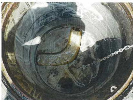
汚水枥-④⑩ 枥内部全景
