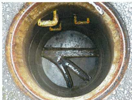
汚水桝-29 桝内部全景
