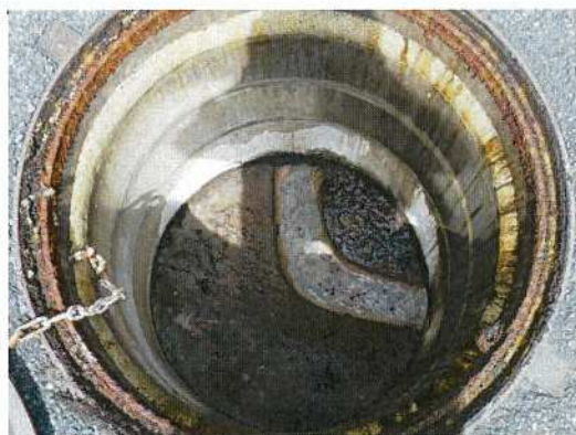
汚水枥-④① 枥内部全景
