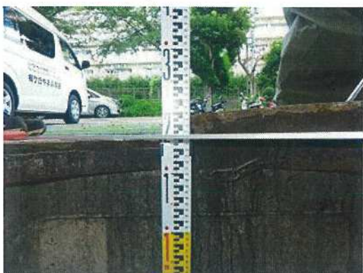
雨水桝-24 桝深さ測定状況
