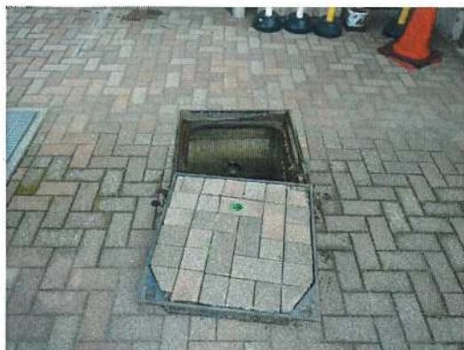
雨水桝-55 調査前
