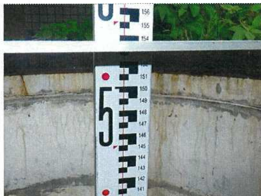
雨水桝-60 桝深さ測定近景
