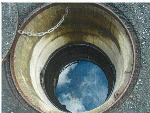
雨水桝-38 桝内部全景
