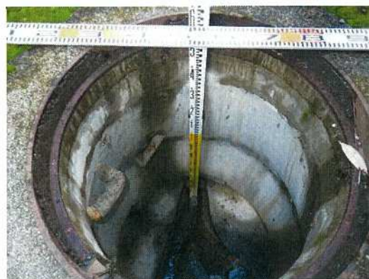
汚水枥-③⑦ 枥深さ測定状況
