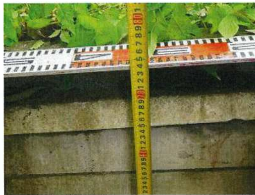
雨水桝-20 配管深さ測定近景(21側)
