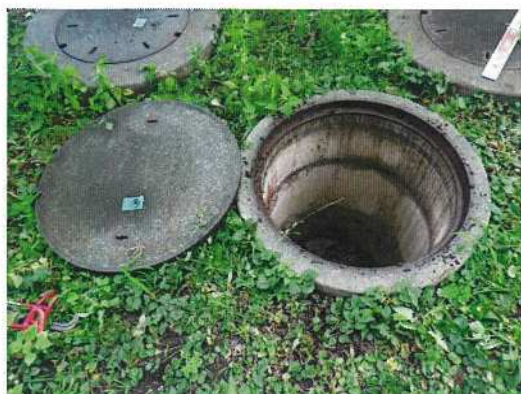
汚水桝-②④ 調査前
