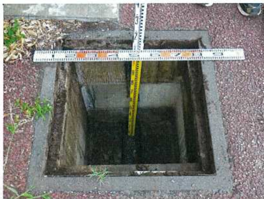
汚水枥-⑥ 枥深さ測定状況
