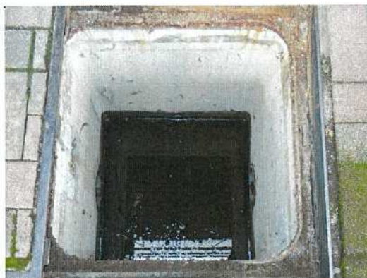
雨水桝-56 桝内部全景
