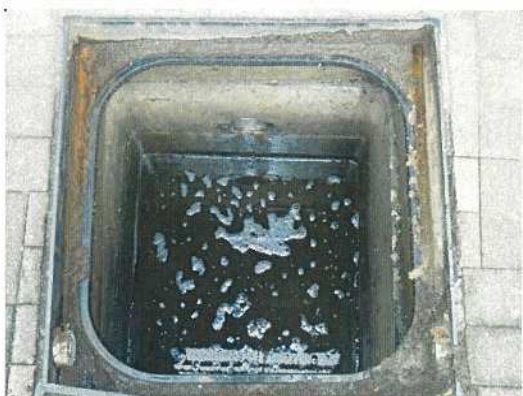
雨水桝-55 桝内部全景
