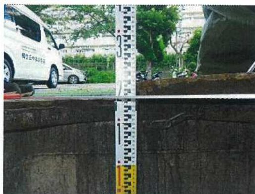
雨水桝-24 桝深さ測定近景
