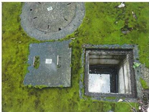
雨水桝-40 調査前
