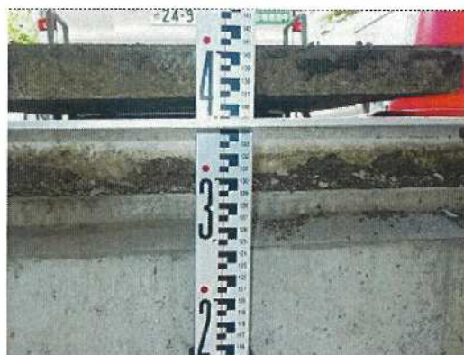
雨水桝-26 桝深さ測定近景
