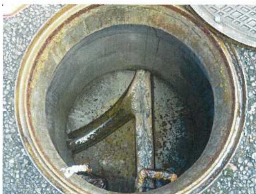
汚水桝-38 桝内部全景
