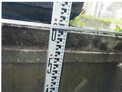
汚水桝-⑱ 桝深さ測定近景
