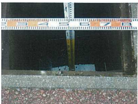
雨水桝-18 桝深さ測定状況
