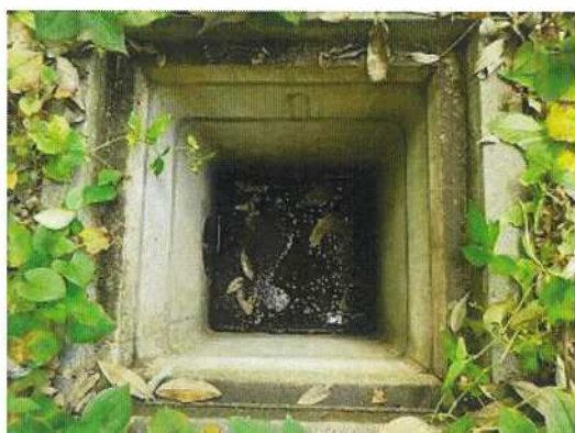
雨水桝-19 桝内部全景
