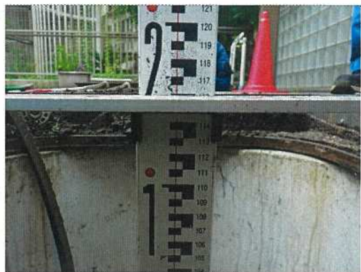
雨水桝-50 桝深さ測定近景
