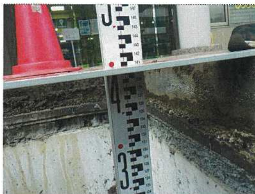
雨水桝-59 桝深さ測定近景
