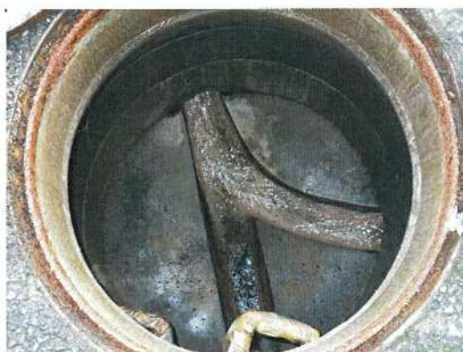
汚水桝-③① 桝内部全景
