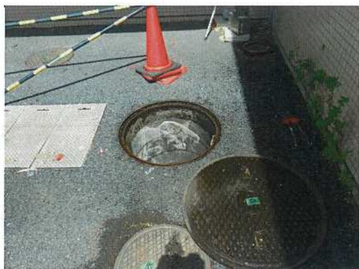
汚水枥-④⑩ 調査前
