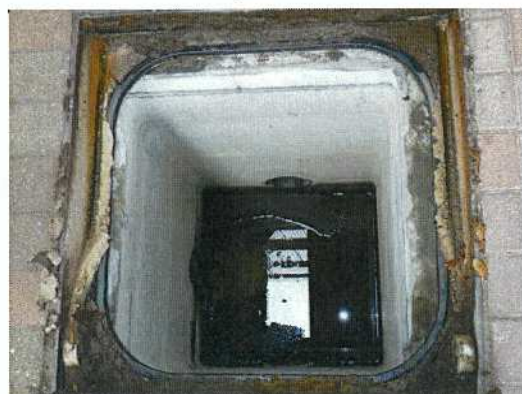
雨水桝-58 桝内部全景
