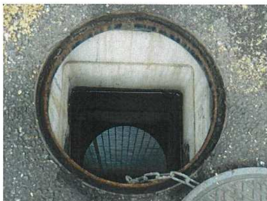
雨水桝-44 桝内部全景
