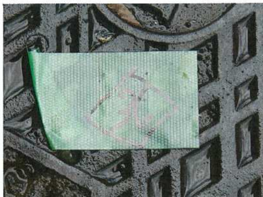
雨水桝-36 調査前
