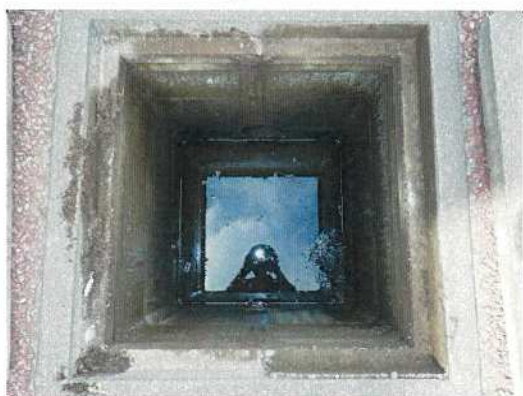
雨水桝-16 桝内部全景
