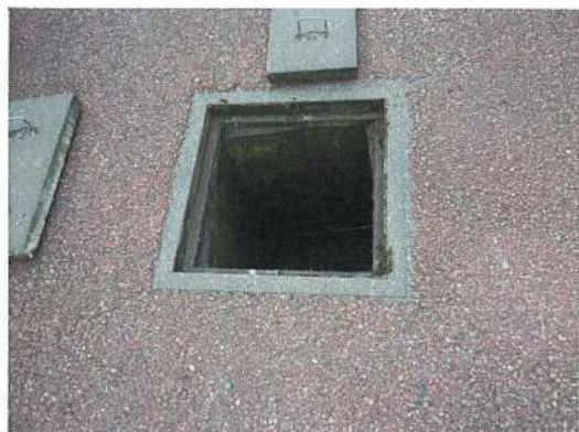
雨水桝-18 調査前
