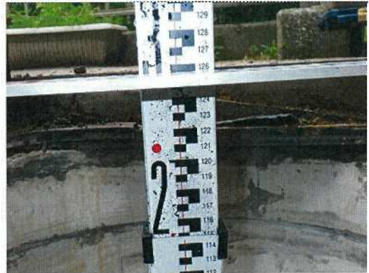
雨水桝-51 桝深さ測定近景
