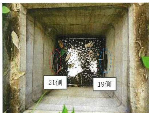
雨水桝-20 桝内部全景
