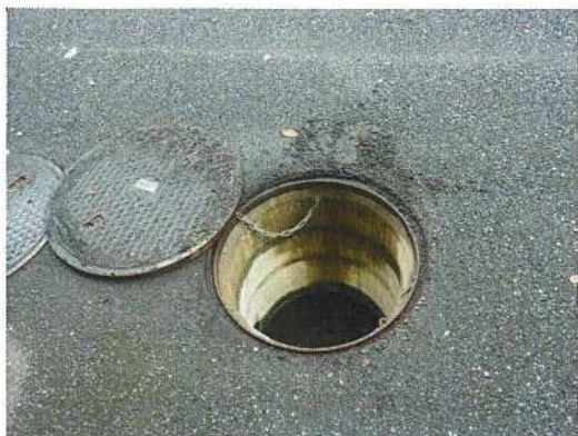
雨水桝-38 調査前
