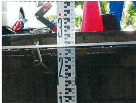
雨水桝-25 桝深さ測定近景
