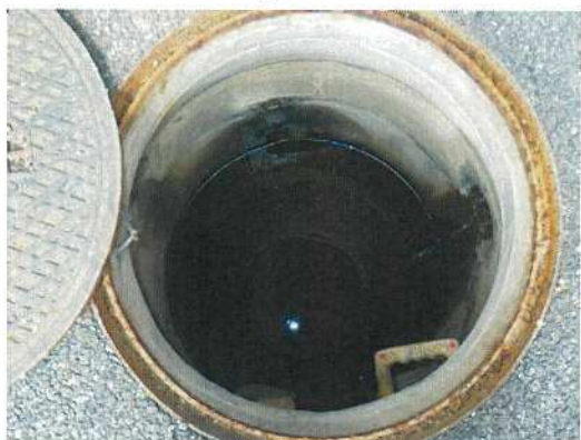
雨水桝-67 桝内部全景
