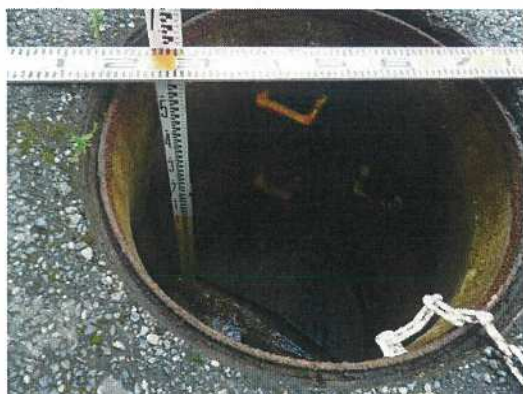
汚水桝-③⑩ 桝深さ測定状況
