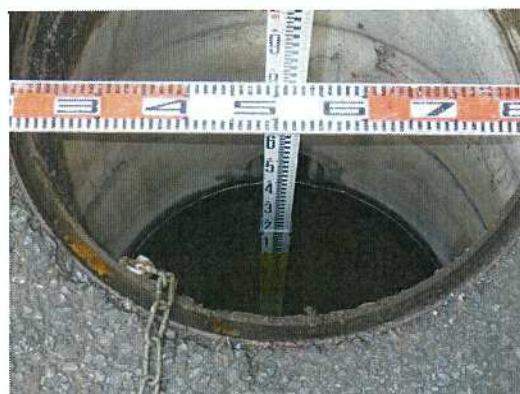
雨水桝-65 桝深さ測定状況
