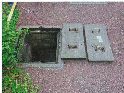
汚水桝-⑰ 調査前
