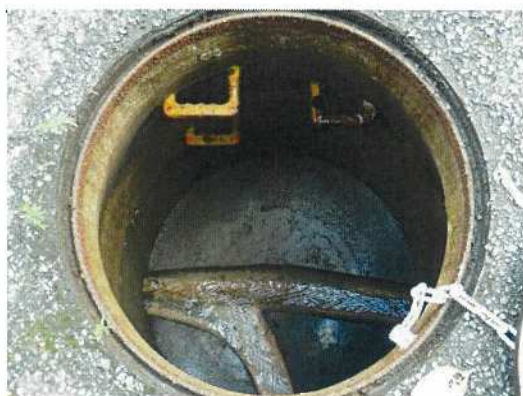
汚水桝-③⑩ 桝内部全景
