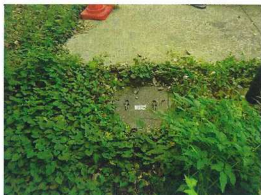
雨水桝-19 調査前
