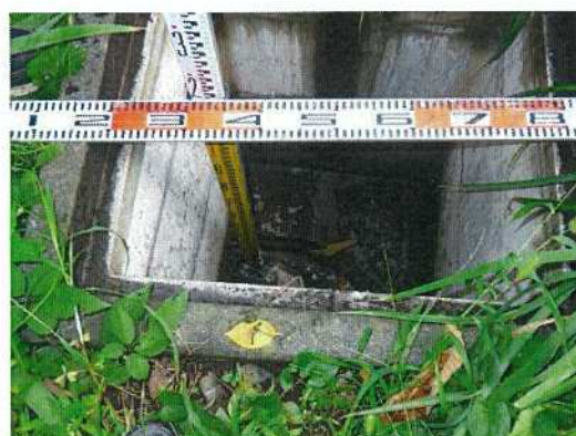
汚水桝-⑬ 桝深さ測定状況
