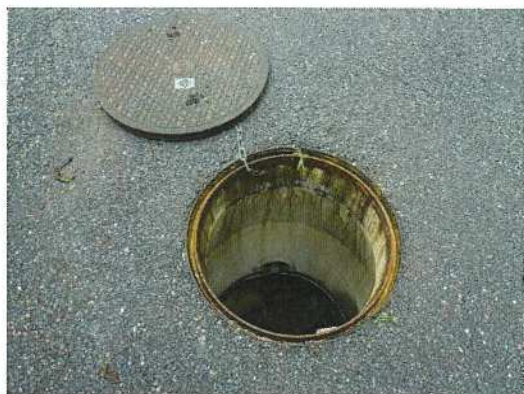
雨水桝-63 調査前
