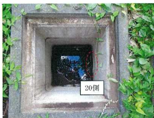
雨水桝-21 桝内部全景
