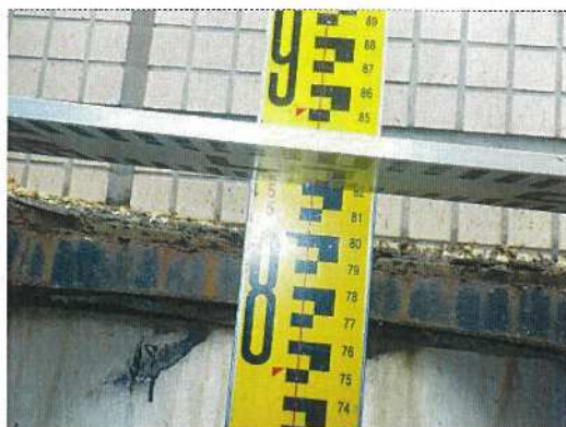
雨水桝-44 桝深さ測定近景
