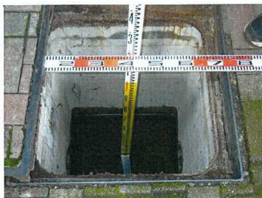
雨水桝-56 桝深さ測定状況
