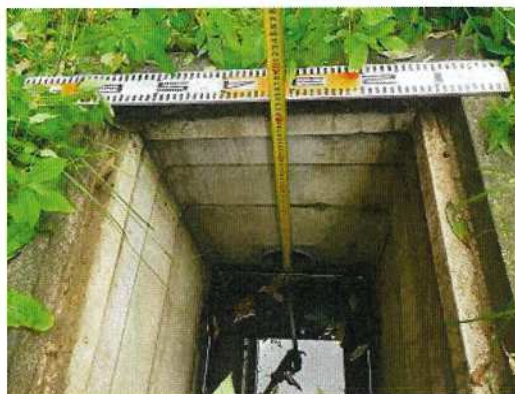
雨水桝-20 配管深さ測定状況(21側)
