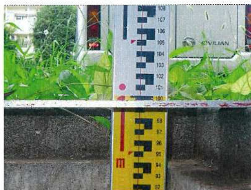
雨水桝-21 桝深さ測定近景
