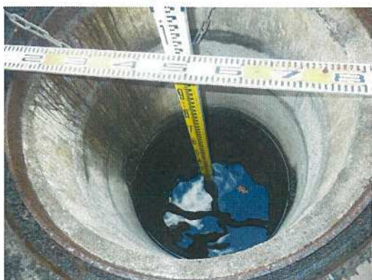
雨水桝-37 桝深さ測定状況
