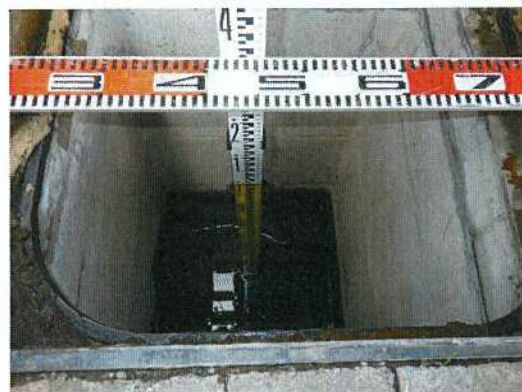
雨水桝-58 桝深さ測定状況
