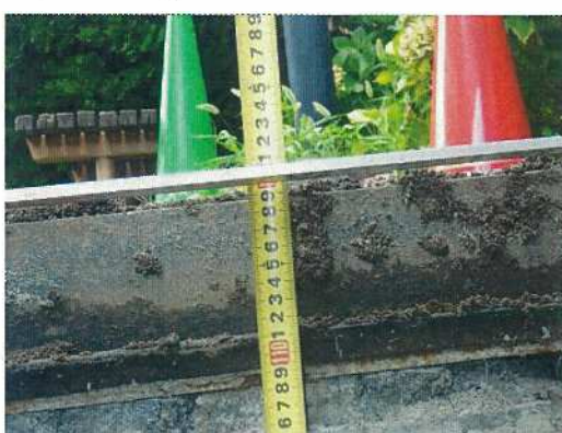
雨水桝-59 配管深さ測定近景 (60側)
