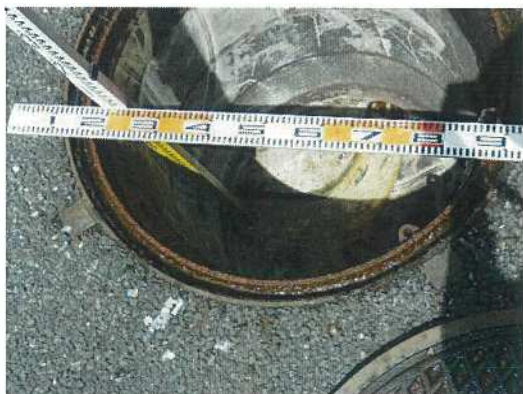
汚水枥-④⑩ 枥深さ測定状況
