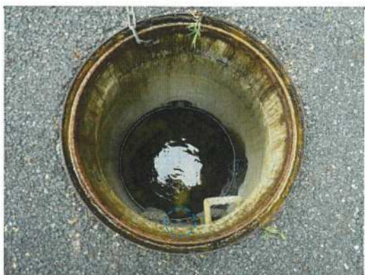
雨水桝-63 桝内部全景
