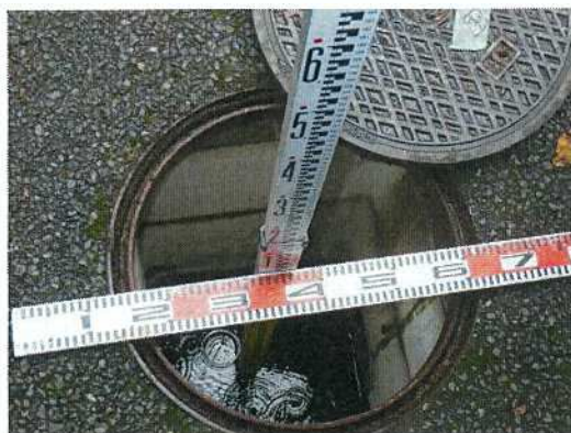
雨水桝-36 桝深さ測定状況
