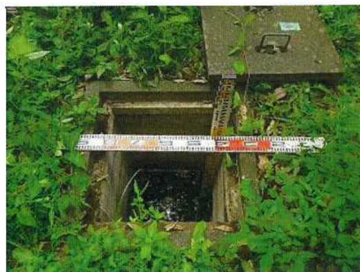
雨水桝-20 桝深さ測定状況
