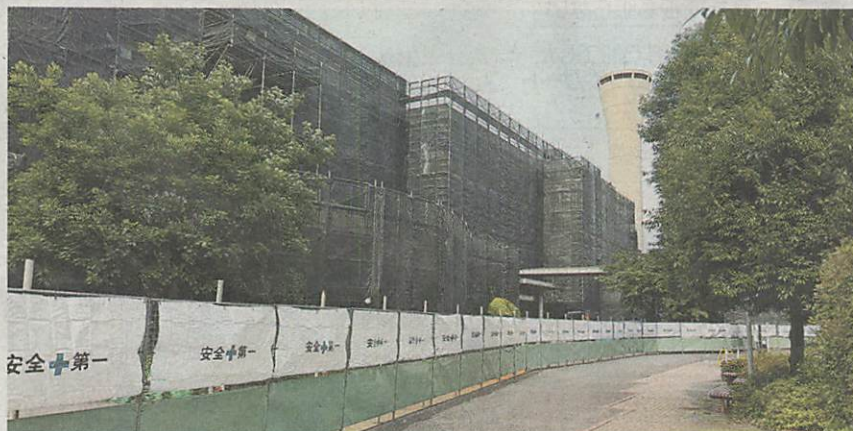
大規模改修工事が進む特別養護老人ホーム「桐ヶ丘やまぶき荘」(東京都北区)
